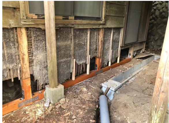
腐食部分の交換
