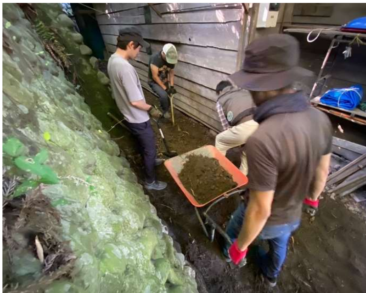
人力での掘削作業
