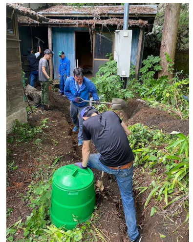
排水管の為の穴掘り
